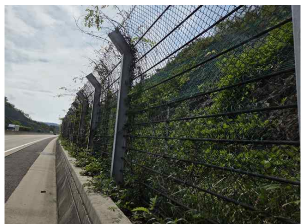
도로, 낙석방지울타리 전경
